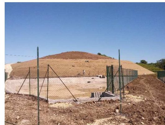
Figure 29 Réhabilitation de la décharge du Moule - Source Observatoire des déchets de GPE
