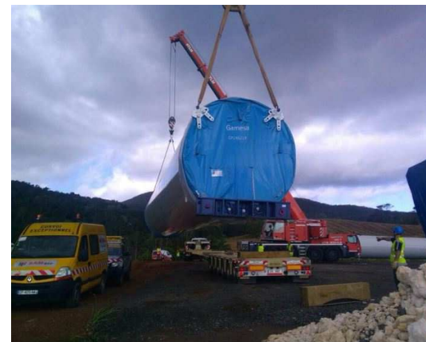
Figure 54 Acheminement des éoliennes vers Sainte-Rose
